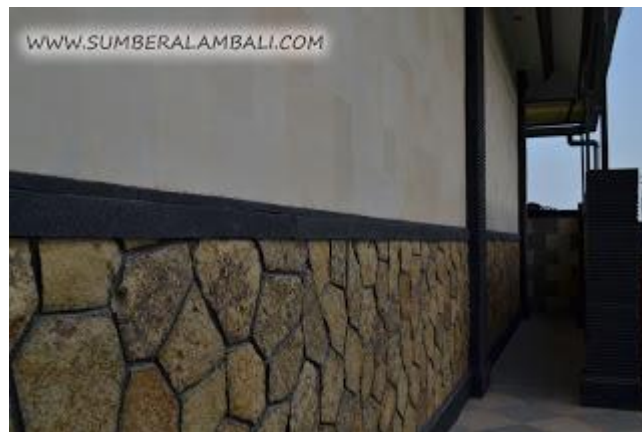
Aplikasi pemasangan batu alam emping
