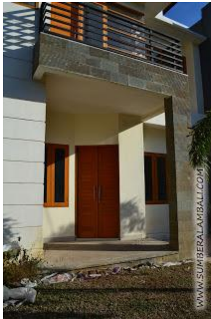
Aplikasi pemasangan batu alur pada pilar rumah
