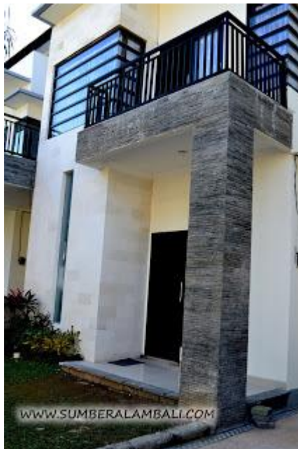
Aplikasi pemasangan batu alam untuk tiang rumah
