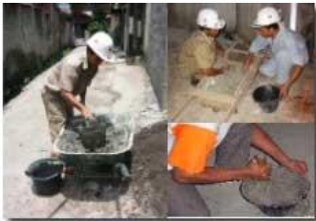
Pencampuran dengan tangan (manual)
