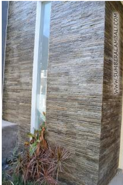
Aplikasi pemasangan batu alam andesit untuk dinding luar rumah
